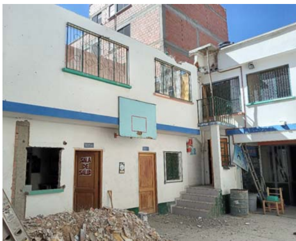
Renovierungsarbeiten am Maya Paya Kimsa-Tageszentrum
